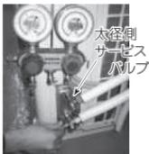
4 太径側サービスバルブのスピンドルを、すぐ閉じることができるようあらかじめ、閉じた状態から90°開いた半開きにします。
