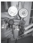
5 冷房運転を行いません。40~60秒間運転しますと、連成計の圧力が0.049MPa(ゲージ圧)になりますので、太径側サービスバルブのスピンドルを右いっぱいにまわして0MPaで確実に閉じます。チャージホースを外しキャップを取り付けます。
