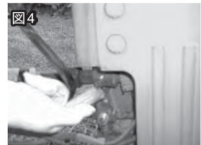
低圧側バルブ(青)閉 高圧側バルブ(赤)閉
