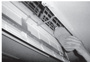
フィルターを外し注水
